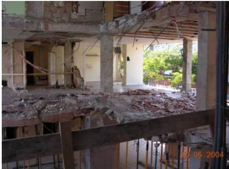
La explosión hizo desaparecer literalmente la mitad del suelo de la vivienda (el forjado existente entre la planta primera y la baja), pero además agujereó el forjado entre las plantas sótano y baja, entre las plantas primera y segunda e incluso el existente entre las plantas segunda y tercera. El techo de la planta tercera llegó también a dañarse, aunque sin llegar a ser agujereado (ver Fotografía 3).
