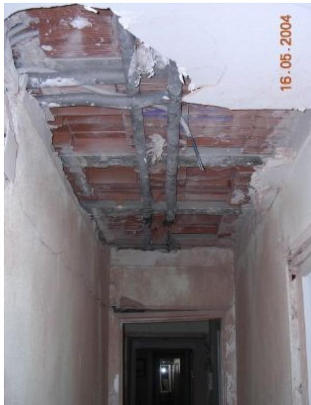
Además de los daños en el forjado, también el hueco del ascensor resultó literalmente arrasado de arriba a abajo, quedando el ascensor comprimido como un acordeón en el fondo del hueco. Sin embargo, las escaleras donde se encontraban los geos no llegaron a derrumbarse.
